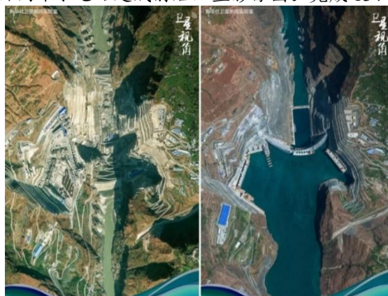
2018年1月水电站建成前
